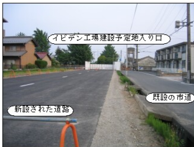
舗装が完了したイビデン専用道路
