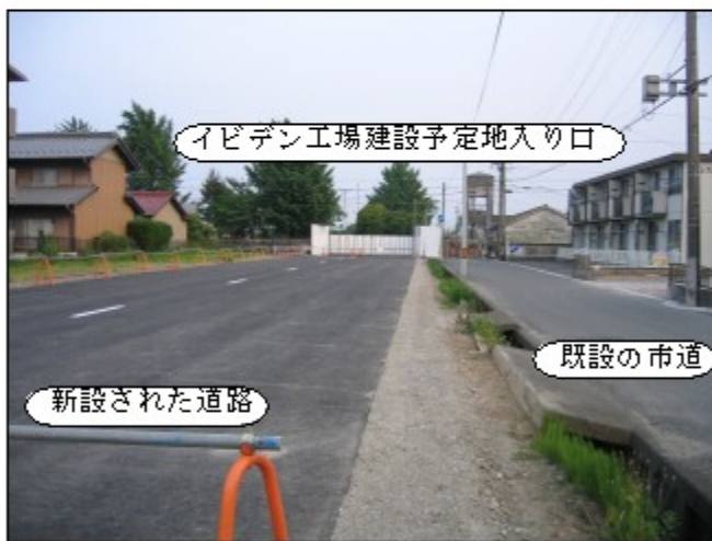
舗装が完了したイビデン専用道路
