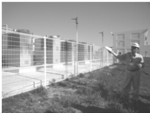
屋外に16台設置されている小型パ イオガスコージェネレーション
