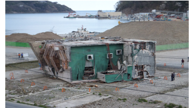
津波によりビルが横転。この写真は、女川町立病院がある高台から撮影。津波はこの高台にまで押し寄せ、病院も浸水しています。
