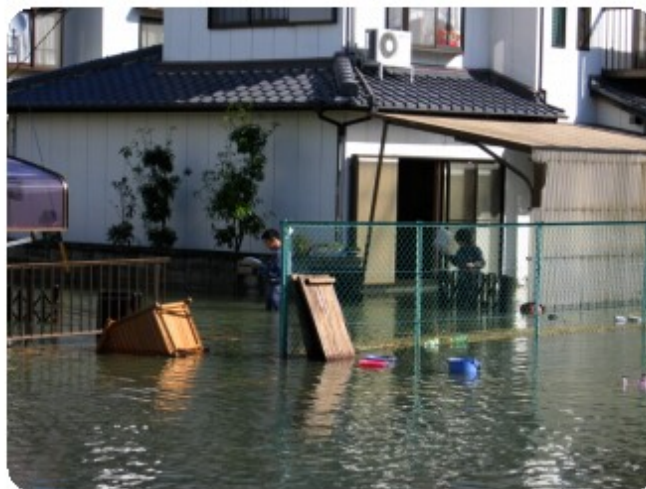
荒崎・島町内 床上浸水の被害が集中した辺り
